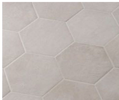
Pavimentazione stuccata con Keracolor FF
