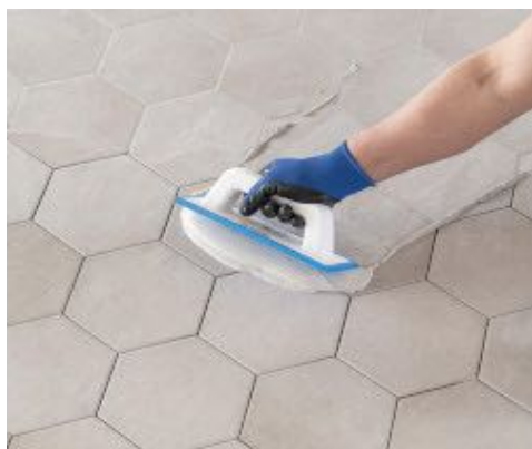
Stesura di Keracolor FF con spatola MAPEI
